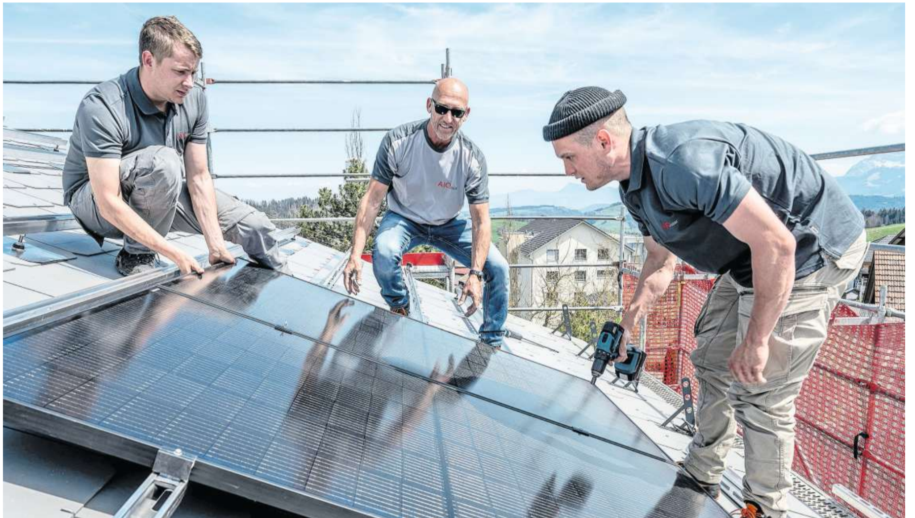
Monteure der Firma AIO Solar aus Ruswil montieren eine Solaranlage auf dem Dach des Berghotels Menzberg.
